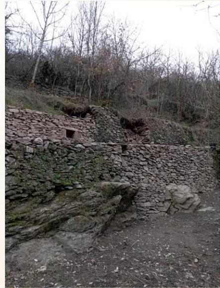
Le sentier du Salès a été restauré (murs de soutènement, drainage, aplanissement) pour faciliter la déambulation des personnes. De même les murets ont été défrichés et renforcés quand nécessaire.
