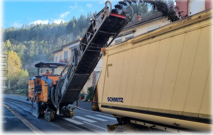
Rabotage avant la pose de l'enrobé
